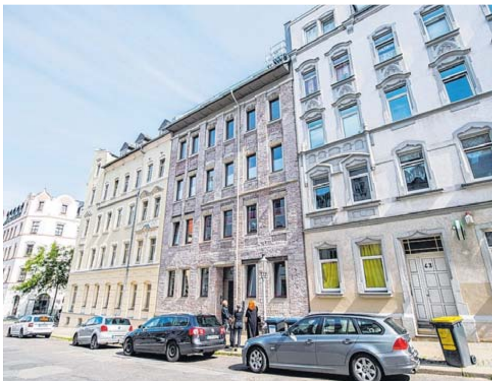
Die rötliche Ziegelsteinfassade gab dem Haus den Namen Casa Rossa. Auch die Wände im Treppenhaus blieben unverputzt. Die Wohnungen sind komplett vermietet.
